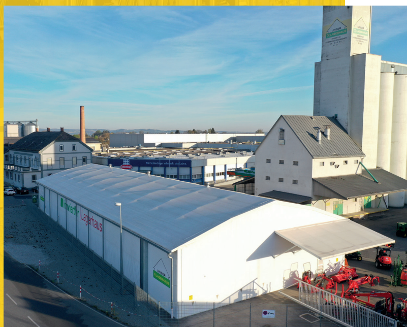
Entrepôt de stockage
