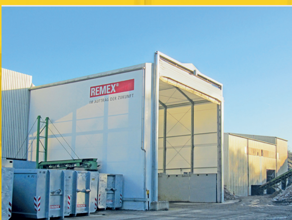
Hall pour le secteur du recyclage
